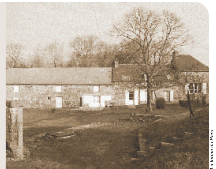
La ferme du Parc
