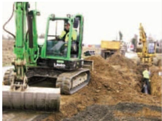
*La pose d'un réseau pluvial par l'entreprise Sacer est le premier travail à réaliser pour ce chantier important. Il nous permettra de terminer cette "liaison sécurisée pour les véhicules roulants, les vélos, et les piétons" entre la route de Dinard et la route de Ploubalay.*
